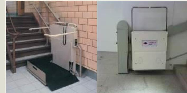
figura 31- plataforma elevatória inclinada
