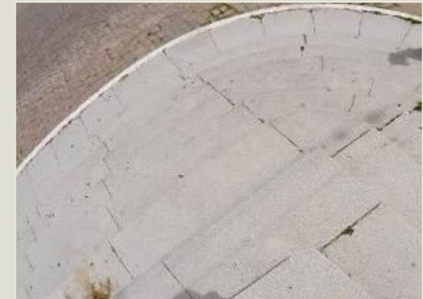
figura 16- Escada principal em granitina a ser substituída por arenito
