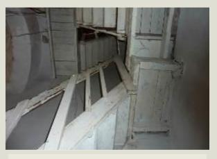
figura 28- Escada acesso a torre a ser retirada e executada nova
