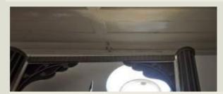
figura 13- forro sacristia a ser retirado e construído novo conforme o existente
