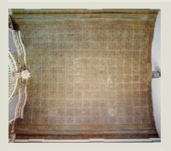
figura 15- forro metálico a ser restaurado
