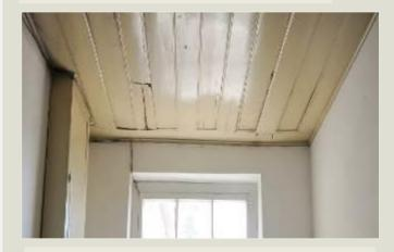
figura 12- forro consistório a ser retirado e construído novo conforme o existente
