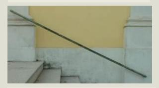
figura 29- Corrimão metálico fachada principal a ser restaurado
