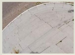
figura 16- Escada principal em granitina a ser substituída por arenito
