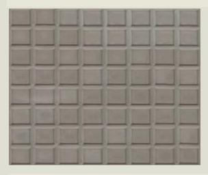
figura 36 – Ladrilho hidráulico externo a ser executado – calçada General Marques
