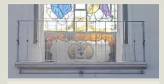
figura 23- Gradil balcões internos em ferro forjado a ser restaurado
