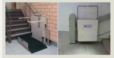
figura 31- plataforma elevatória inclinada
