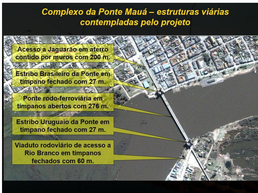
Figura 03: Ponte Internacional Barão de Mauá – Complexo da Ponte Mauá – estruturas viárias contempladas pelo projeto.
