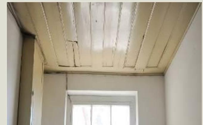
figura 12- forro consistório a ser retirado e construído novo conforme o existente
