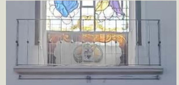
figura 23- Gradil balcões internos em ferro forjado a ser restaurado
