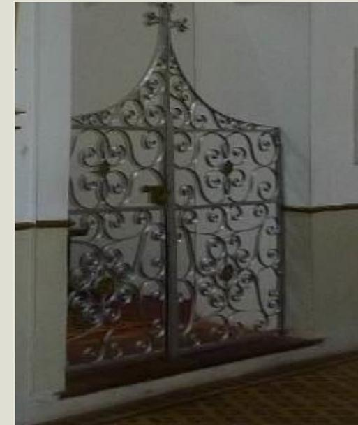
figura 22- Gradil Capela Nosso senhor dos Passos em ferro forjado a ser restaurado
