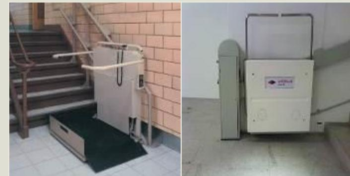
figura 31- plataforma elevatória inclinada
