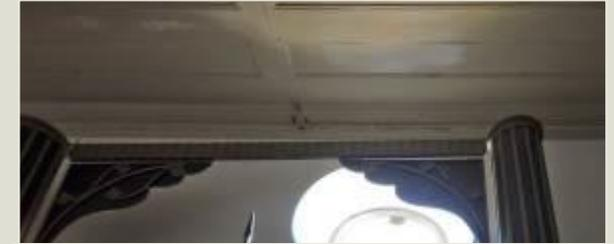
figura 13- forro sacristia a ser retirado e construído novo conforme o existente
