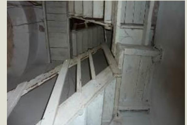
figura 28- Escada acesso a torre a ser retirada e executada nova
