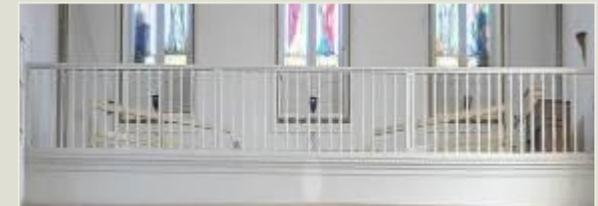
figura 30- Guarda-corpo corro em madeira a ser restaurado
