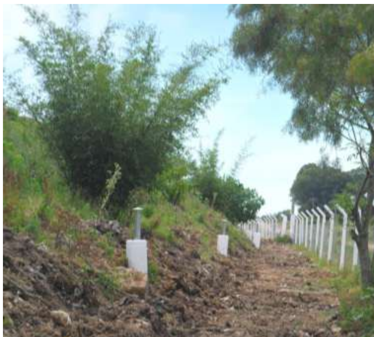
Figura 03: Vegetação roçada, sobre os drenos perimetrais.
