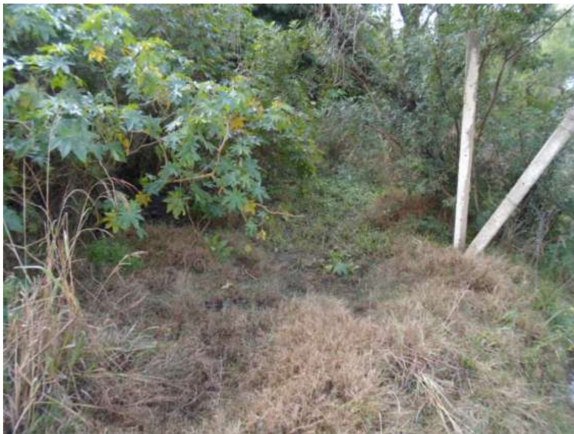
Figura 05. Ponto crítico de soterramento do dreno perimetral.
