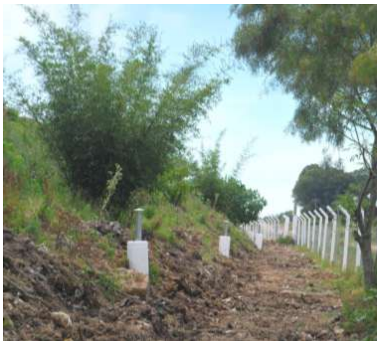
Figura 03: Vegetação roçada, sobre os drenos perimetrais.
