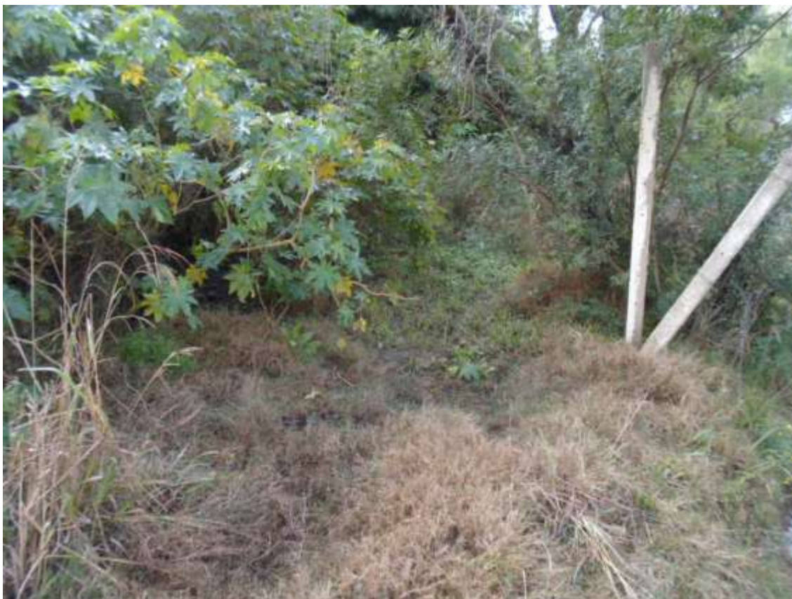
Figura 05. Ponto crítico de soterramento do dreno perimetral.
