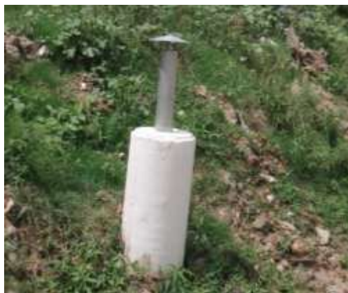
Figura 06: Dreno de gás.
