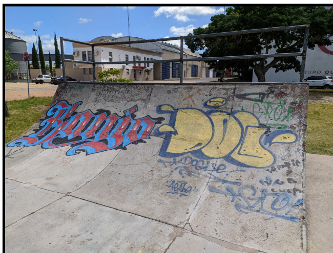
Figura 6 – Recuperação de rampa existente
