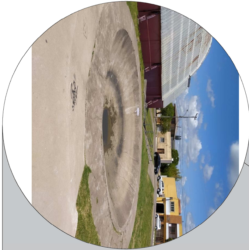
OBSTÁCULO A SER DEMOLIDO:9,01 m³ 1. Demolição da borda de alvenaria revestida com argamassa de espessura aprox. de 20 cm; 2. Aterrar a superfície até o nível de projeto.
