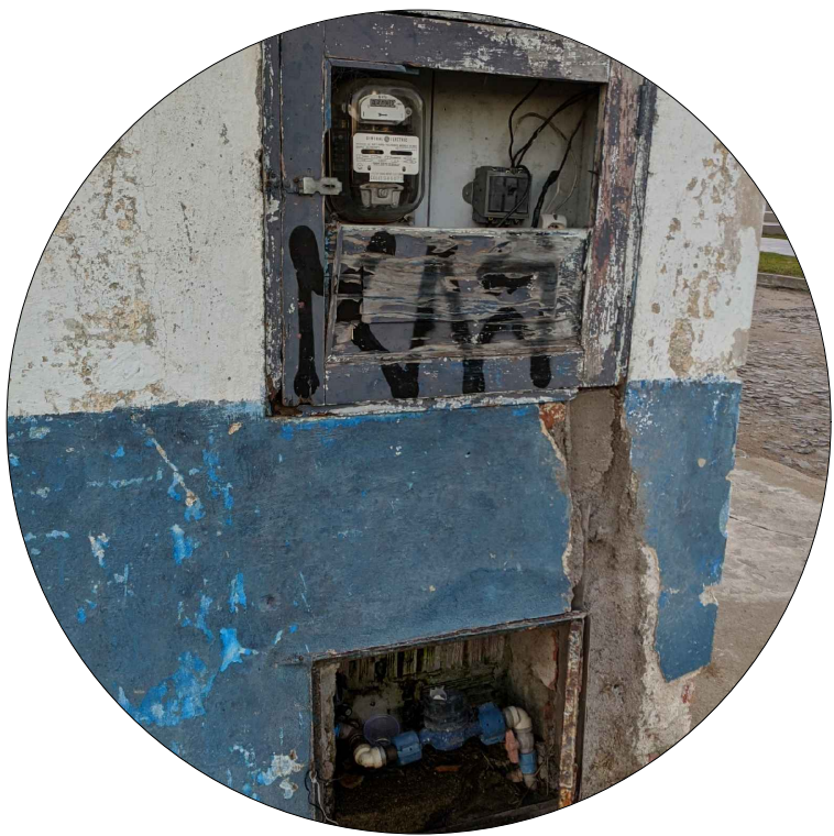
MEDIDOR DE LUZ E HIDRÔMETRO A SUBSTITUIR
