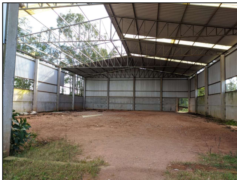
Vista interna do galpão
