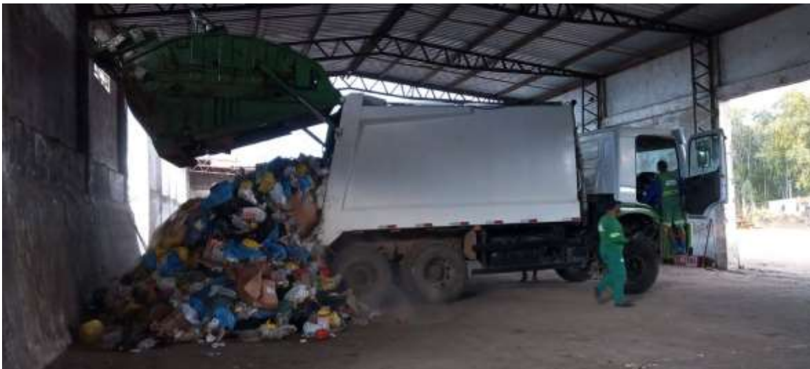
Figura 34. Área da antiga Estação de Transbordo do Município de Jaguarão, que era localizada no Complexo Sena.
