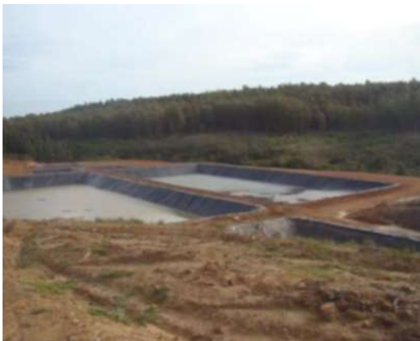
Figura 38. Lagoas de estabilização de lixiviados no aterro sanitário Metade Sul, Candiota/RS.
