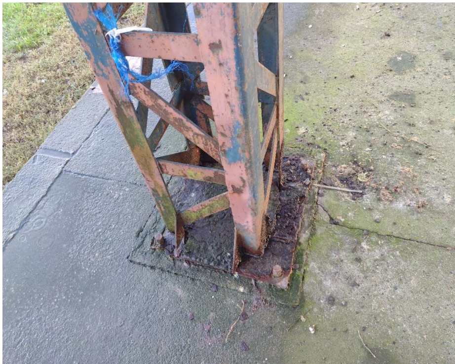
Imagem Pilares – Estrutura Metálica – Comércio Informal de Jaguarão “a mobilizar”;
