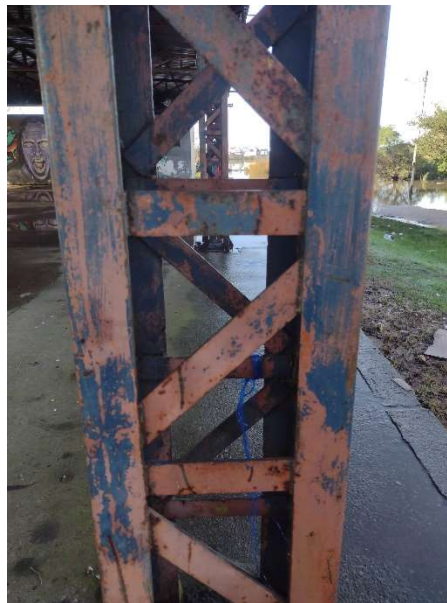
Imagem Pilares – Estrutura Metálica – Comércio Informal de Jaguarão “a mobilizar”;
