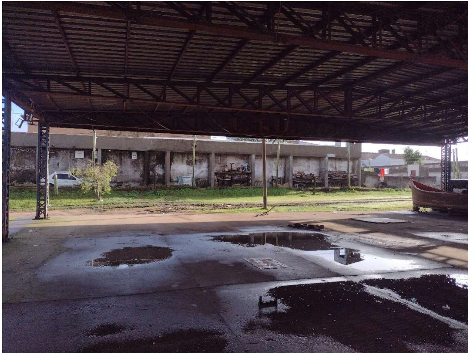
Imagem Fachada Frontal Predial – Estrutura Metálica – Comércio Informal de Jaguarão “a mobilizar”;
