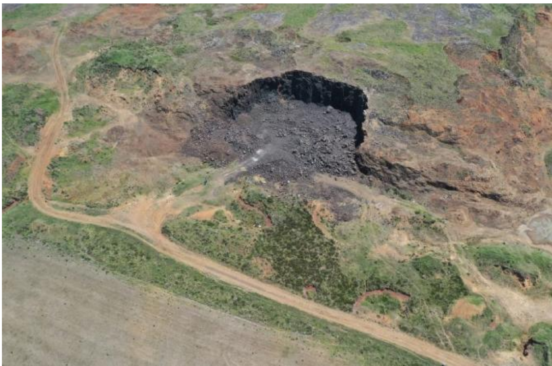
Figura 3 - Imagem aérea obtida por drone, evidenciando o talude subvertical em maciço basáltico, com exposição da face de lavra e acesso à crista para operações de perfuração e carregamento.
